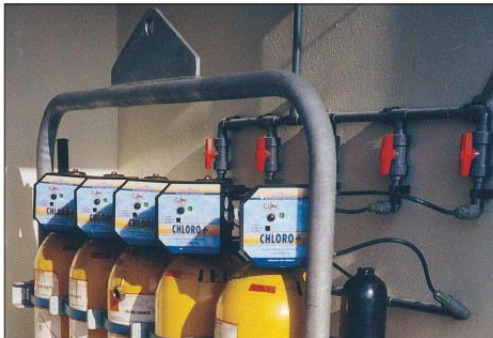
Fig D : Sous-tirage en parallèle et en dépression à travers 5 régulateurs de vide Chloro+ type 805 ST, à montage direct sur les robinets de bouteille = sécurité
