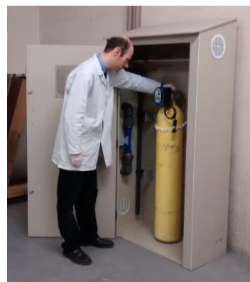
Armoire à Chlore CIFEC – modèle à porte - sans seuil à franchir
